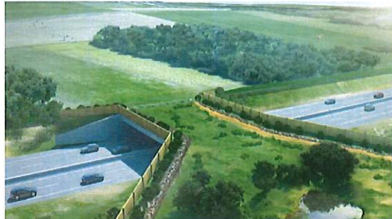
Exemple d'ouvrage en projet sur la commune de Viry : passage faune permettant de relier le Salève à la plaine genevois
