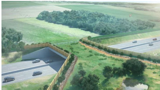
Exemple d'ouvrage en projet sur la commune de Viry : passage faune permettant de relier le Salève à la plaine genevoise
