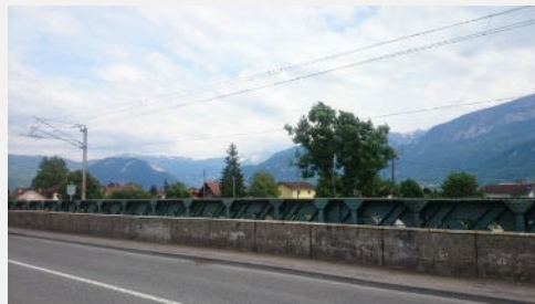
Circulations routières peu qualitatives et à sécuriser-Vue en balcon sur les massifs montagneux
